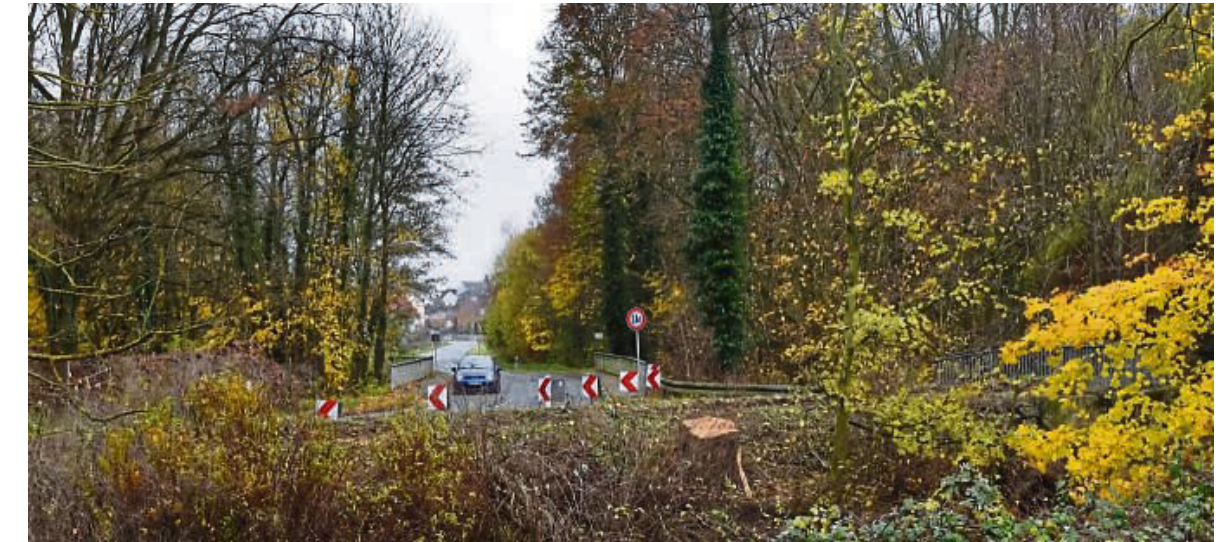
Für zwei Jahre gesperrt wird die L 3115 zwischen Groß- und Klein-Zimmern. Hessen Mobil plant einen Rad- und Gehweg sowie ein neues Brückenwerk – darunter verläuft die Fischtreppe zum Katzensgraben.
