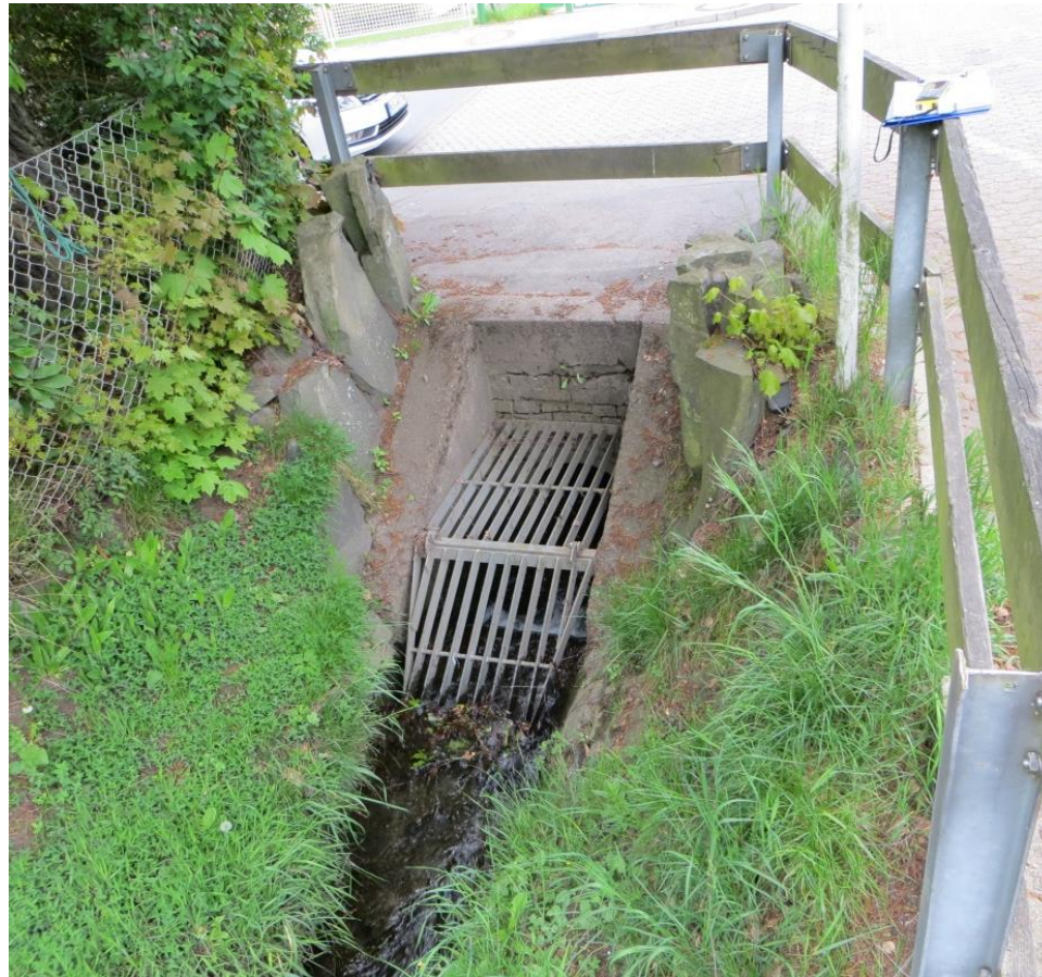
Einlaufrechen vor dem Umbau © Stadt Kassel
