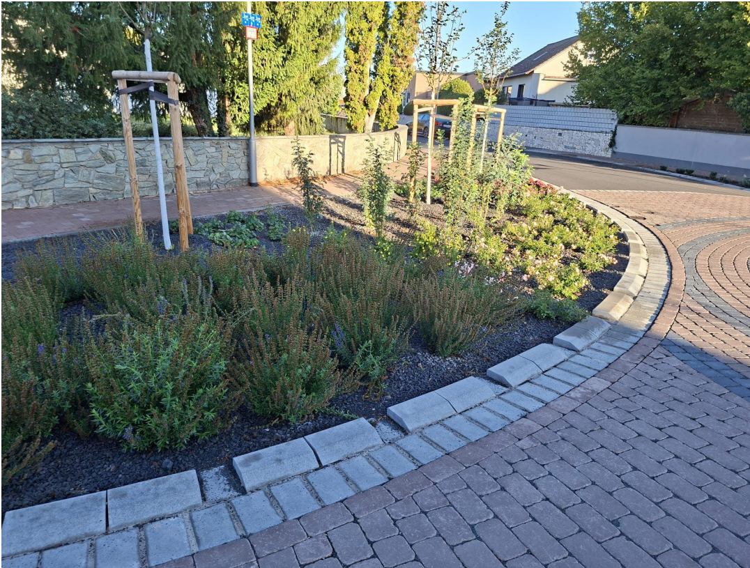
Bepflanzte Versickerungsmulde im Straßenraum
