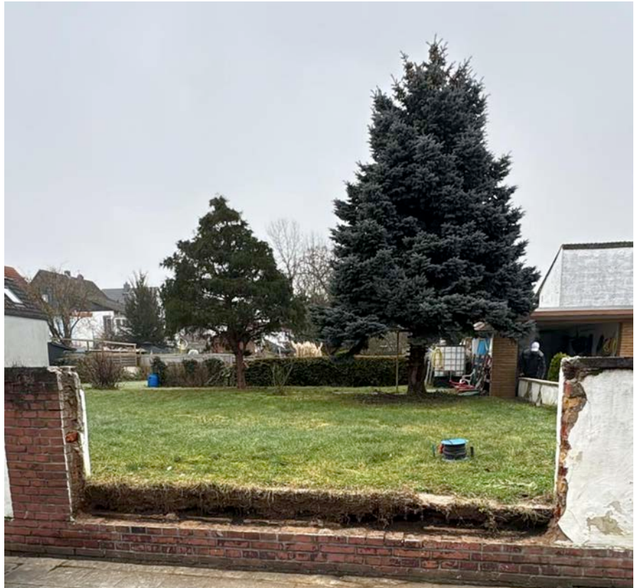
Abbildung: Foto des Grundstücks vor Baubeginn von der Straße aus, Blickrichtung Süden
